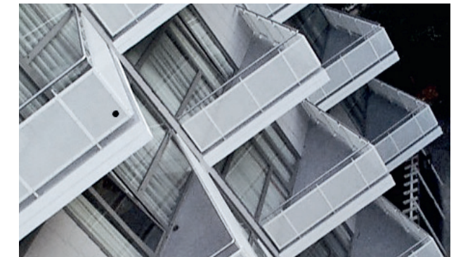
Balkonsanierung einer Hotelanlage
