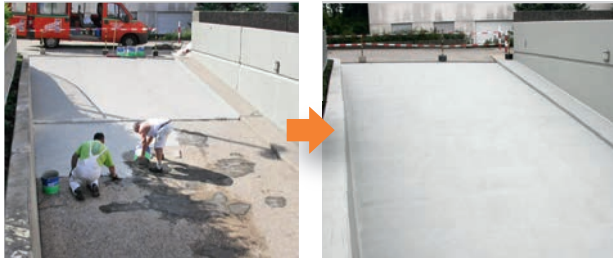
Epoxidharz-Beschichtung einer Tiefgaragenzufahrt (OS 8)
