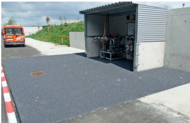
Gewässerschutzbeschichtung einer Lösemittel-Tankstelle
